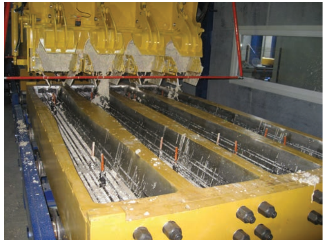
Одновременно с наполнением формы бетонной смесью происходит ее уплотнение на высокочастотной виброустановке
