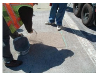
Рис. 5. Поверхность посыпают порошкообразным бокситом
