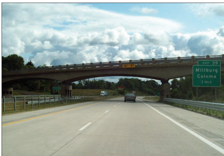
Рис. 3. Фривей I-94 в шт. Мичиган: справа от белой линии — «шумовая полоса», устраиваемая фрезерованием бетона, чтобы разбудить задремавшего водителя, когда правые колеса приблизились к границе полосы движения (в России такие «шумовые полосы» успешно устроены в опытный порядке компанией БиЭйВи ( http://www.bavocompany.ru/production )); в каждом направлении — две полосы движения с цементобетонным покрытием; разделительная полоса в виде газона с гибким ограждением
