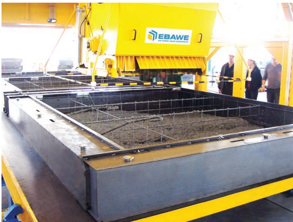
Точное бетонирование очень важно для безупречного качества бетонных элементов
