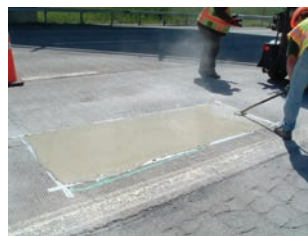
Рис. 4. Горячее разглаживание
