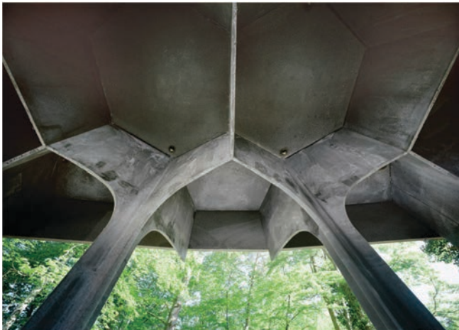
Павильон из сверхпрочного бетона в г. Кайзерслаутерн — первое в мире сооружение с использованием внутреннего ухода с помощью суперабсорбирующих полимеров. Технология была разработана под руководством проф. Мещерина.
