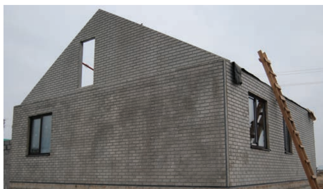
Применение матриц RECKLI в малоэтажном домостроении. Трехслойная стеновая панель заводского изготовления с текстурой RECKLI, имитирующей кирпичную кладку.
