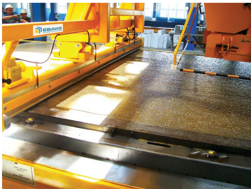
Свежебетонированные бетонные элементы заглаживаются виброрейкой
