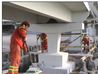
Рис. 6. Опыт применения материалов компании «BASF» для восстановления и защиты бетонных конструкций.
