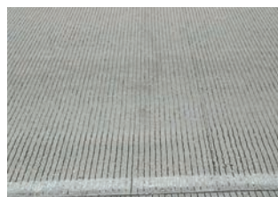
Рис. 2. Покрытие на I-45 в шт. Техас вблизи Хьюстона: срок службы — 13 лет, средняя интенсивность — 178000 авт./сутки, но поперечные бороздки сохранились
