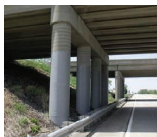
Рис. 1. Железобетонные колонны путепровода, защищенные от коррозии полимерным полотном, армированным стекловолокном (светлая часть внизу колонны — до 2/3 высоты)
