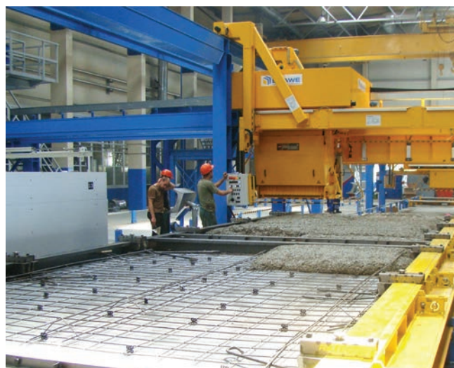
С помощью новых бетонораздатчиков будут изготавливаться будущие внутренние и наружные стеновые панели
