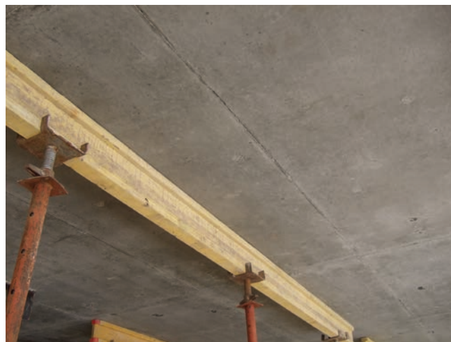
Рис. 7 Общий вид перекрытия, забетонированного с использованием комбинированного метода прогрева бетона
