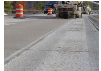
Рис. 5. Установка для шлифовки старого дорожного покрытия: слева — покрытие после шлифовки
