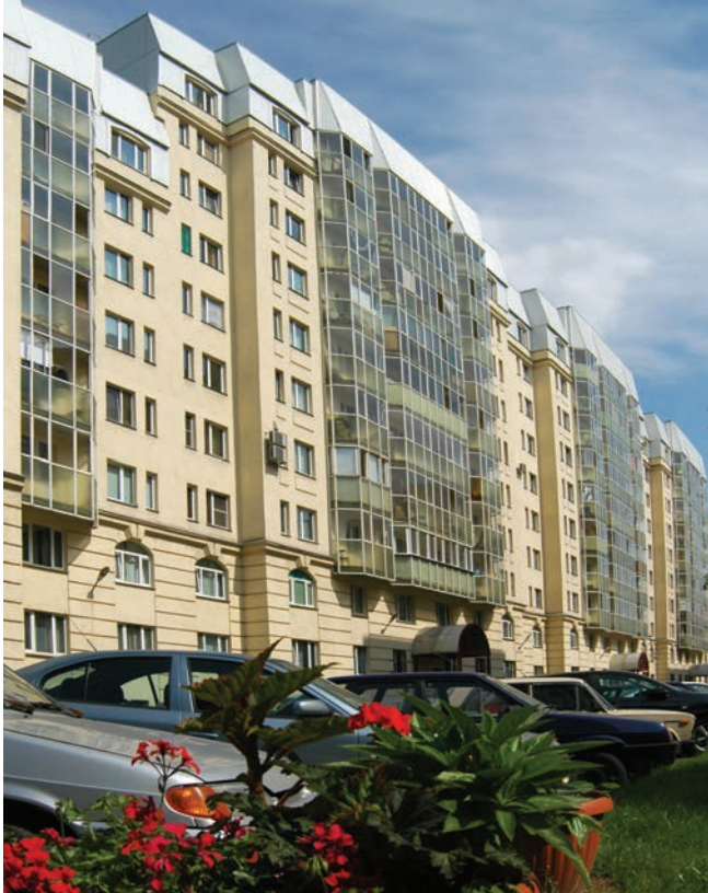
ФОТО Первый в Санкт-Петербурге дом из сборного железобетона, построенный ДСК «Блок» по «бесшовной» технологии.
