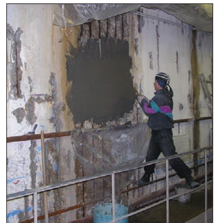
Рис. 4. Нанесение ремонтного материала «СРС 588С».
