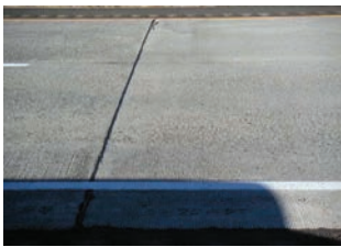
Рис. 1. Покрытие на I-90 в шт. Вашингтон: срок службы — 7 лет, средняя интенсивность — 6800 авт./сутки; поперечные бороздки сохранились только там, где проезжает мало колес
