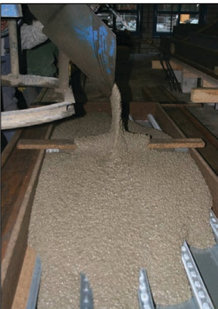
Изготовление испытательной композитной плиты перекрытия с использованием легкого самоуплотняющегося бетона, разработанного Институтом Строительных Материалов Технического Университета Дрездена.
