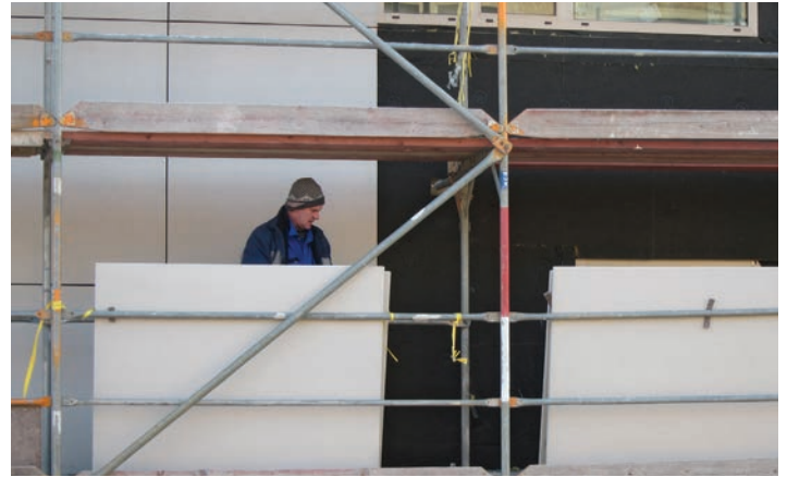
Монтаж фасадных панелей из текстиль-бетона при строительстве новой лаборатории Института Строительных Материалов. Технология текстиль-бетона является одним из основных направлений работы Института.
