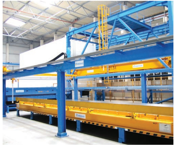
Штабелный стеллаж с подъемно-передаточной установкой, установка чистки паллет и плоттер на новой линии циркуляции паллет
