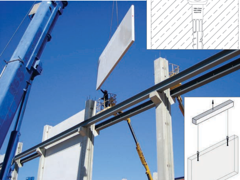
Рис. 4. Подъём с помощью системы Jenka
