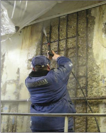
Рис. 2. Подготовка основания. Разрушенный бетон удаляется, с использованием водоструйной установки.
