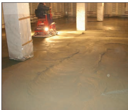
Рис. 5. Затирка упрочняющего материала «СРС ТОП 100».
