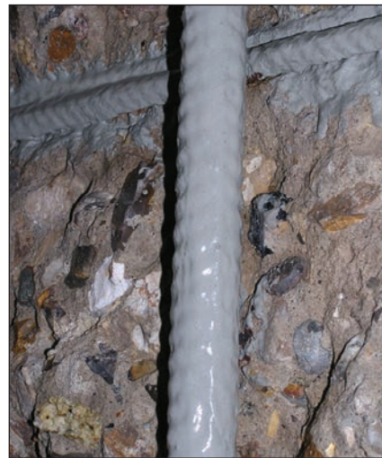
Рис. 3. Обработка арматуры защитным составом «СРС 300».
