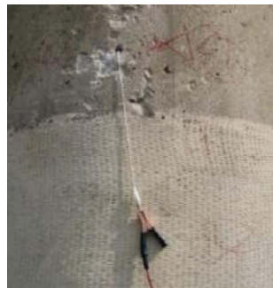
Рис. 2. Соединение электрода со стальным арматурным стержнем
