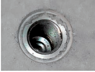
Рис. 3. Гнездо анкера на поверхности ж/б элемента
