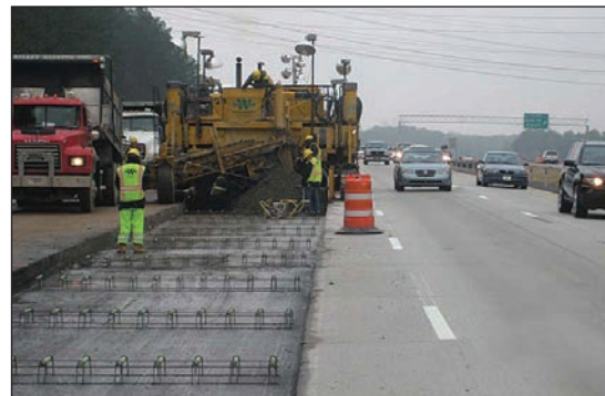
Рис. 19. Замена старой дорожной одежды с асфальтобетонным покрытием на цементобетон на межштатной дороге I-75 вблизи г. Атланта
