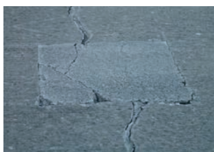
Рис. 1. Цементобетонное покрытие после ремонта строительным раствором
