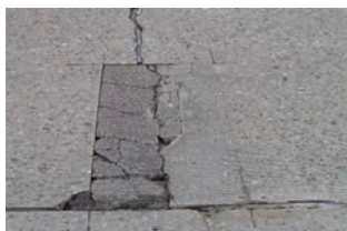
Рис. 2. Цементобетонное покрытие после ремонта асфальтобетонной смесью
