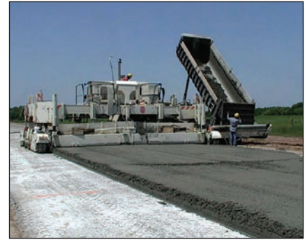
Рис. 1. Современный укладчик бетона в скользящей опалубке, снабженный ленточным транспортером смеси
