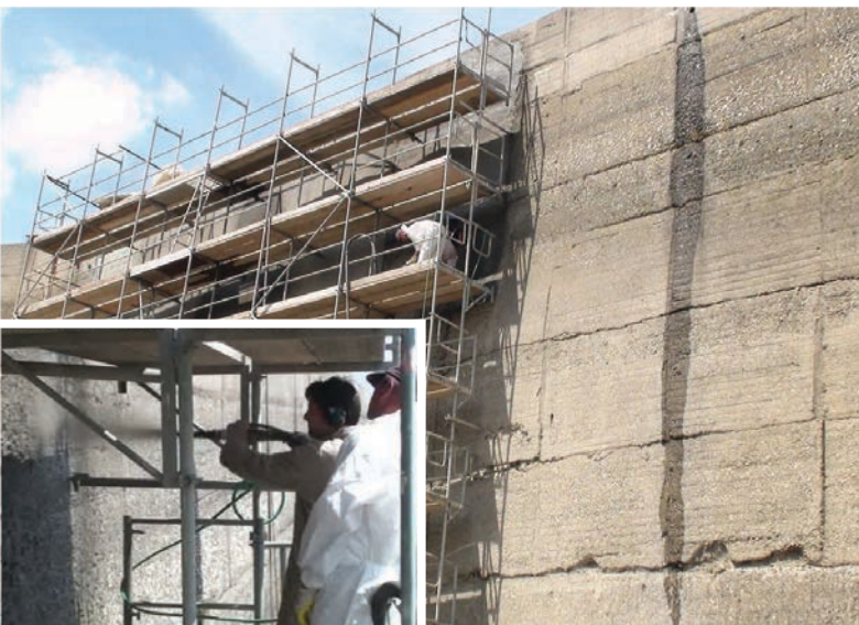
Ремонт стены водного резервуара накопительной электростанции путем нанесения сверхвязкого бетона методом торкретирования. Технология была разработана Институтом Строительных Материалов Технического Университета Дрездена.
