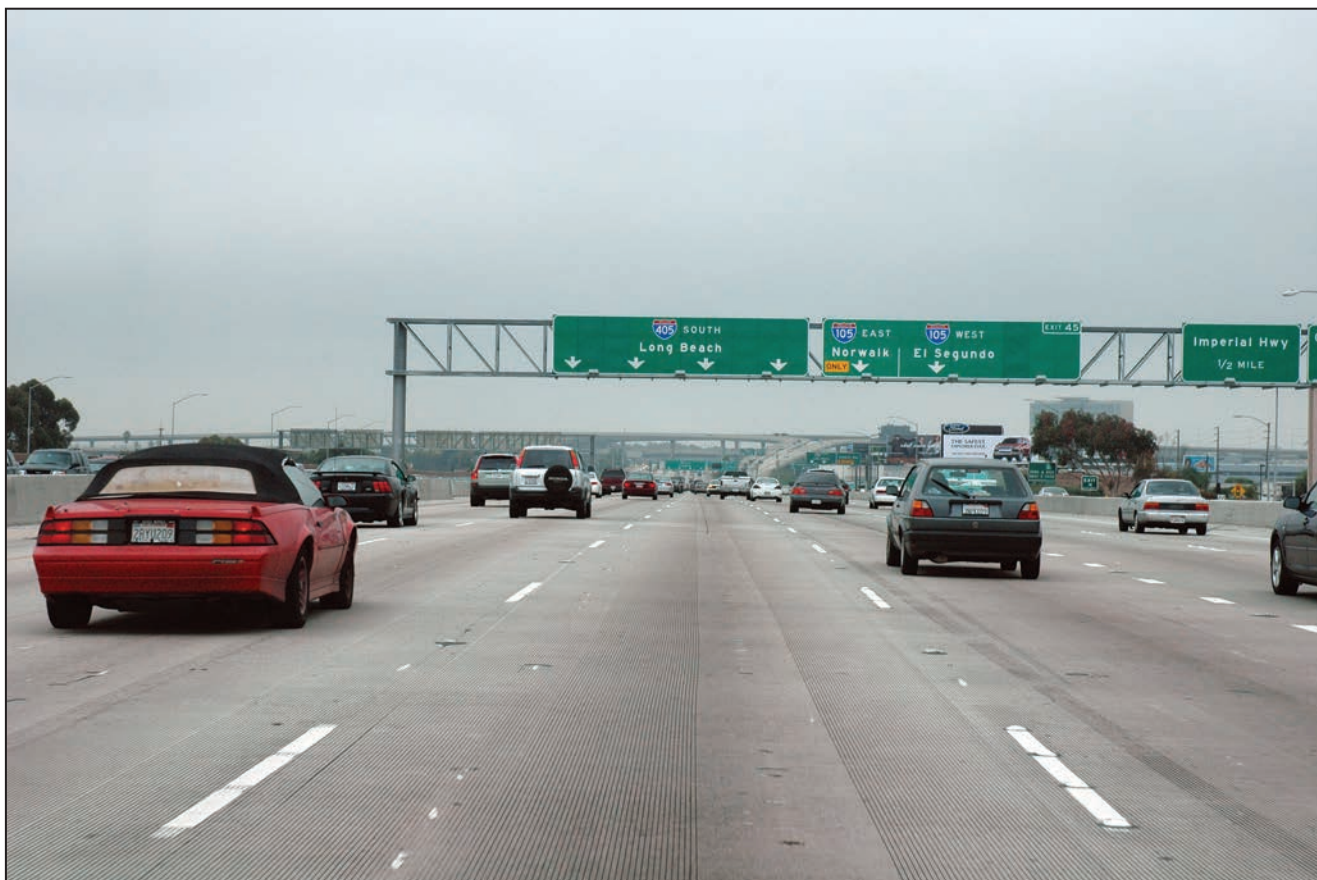
Рис. 2. Фривей I-405 с цементобетонным покрытием в Калифорнии: фривей на этом участке имеет по шесть полос движения в каждом направлении; текстура поверхности цементобетонного покрытия в виде продольных бороздок, исключающих аквапланирование шины на мокрой поверхности во время дождя
